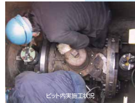
実施工状況例 (FCバルブ)
