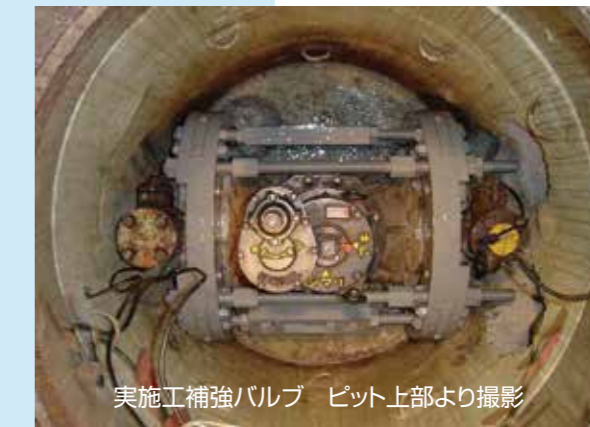
実施工状況例 (FCバルブ)
