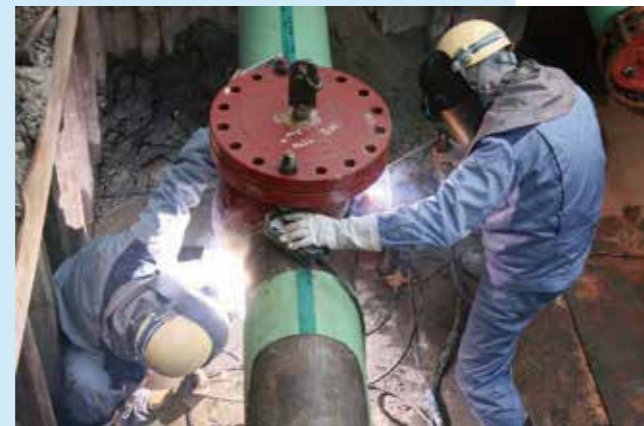
継手溶接(活管状態)
