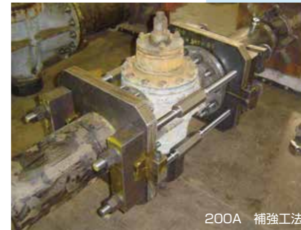
実施工状況例 (FCバルブ)
