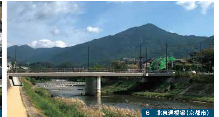
6 北泉通橋梁(京都市)
