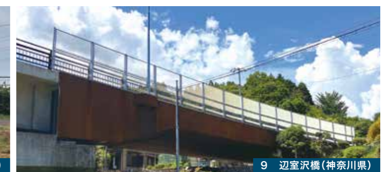
9 辺室沢橋(神奈川県)
