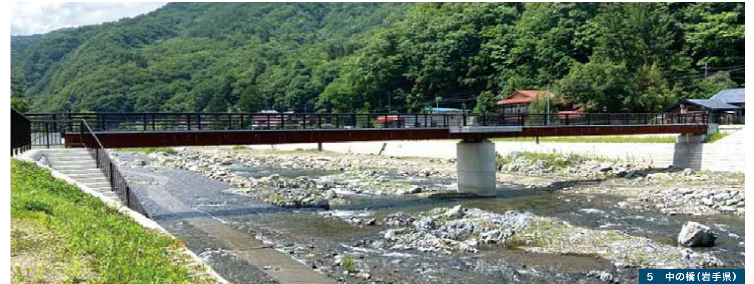
5 中の橋(岩手県)
