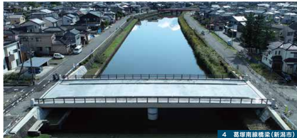
4 葛塚南線橋梁(新潟市)
