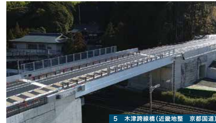
5 木津跨線橋(近畿地整 京都国道)
