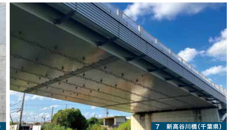
7 新高谷川橋(千葉県)
