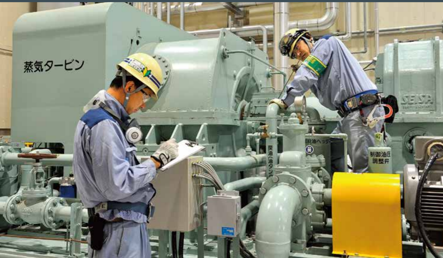
▲ Rubbing check 蒸気タービン総合検査
