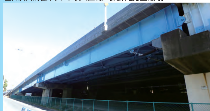
■舞浜大橋右岸ランプ橋（山側）【関東地方整備局】
