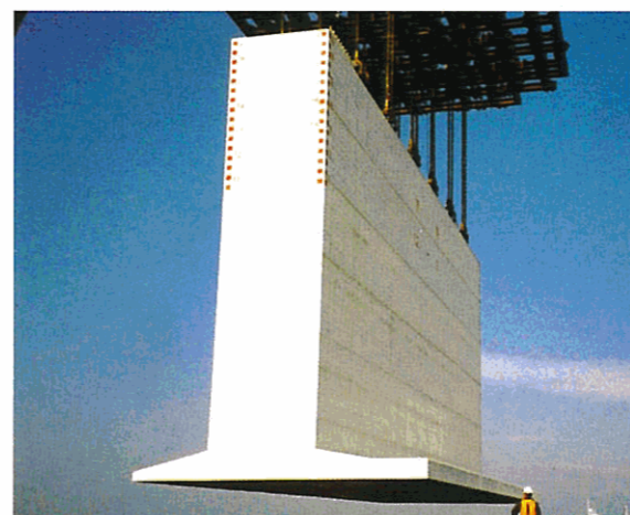
● 第四港湾建設局/北九州港・響灘地区岸壁
