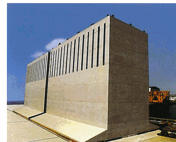
● 横浜市/南本牧ふ頭・外周護岸
