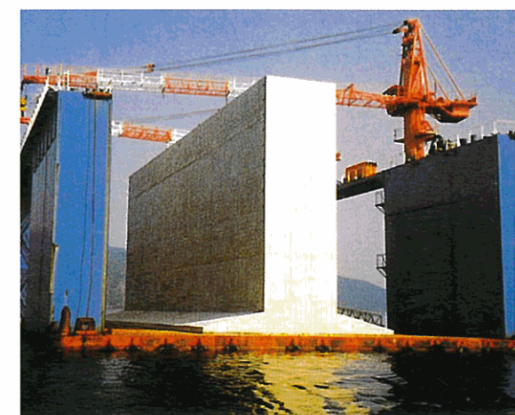
● 愛媛県/深浦漁港・防波堤
