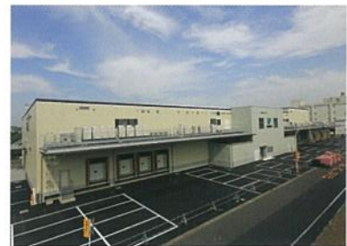
川崎市中央卸売市場青果部 配送棟、パッケージ場建設 卸売場の経営統合に伴う市場高機能化を目的と した再整備
