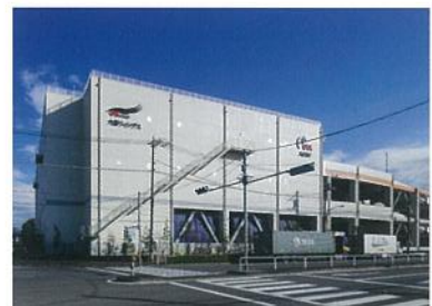
東京都中央卸売市場大田市場花き部 荷捌施設建設 大規模集散機能実現のためのコールドチェーン 対応荷捌施設整備
