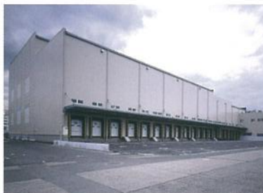
福岡市中央卸売市場鮮魚市場 冷凍冷蔵庫建設 全面再整備の基本計画および基本設計と立体自 動冷凍冷蔵庫の建設
