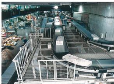
大阪鶴見花き地方卸売市場 自動せり、物流システム 世界最大級の自動せり、自動仕分けや立体自動 倉庫などの物流システム
