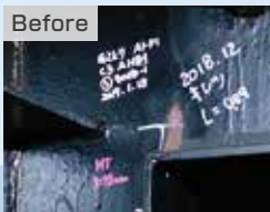
疲労損傷部の補修
