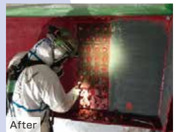
剥離剤による既存塗膜除去
