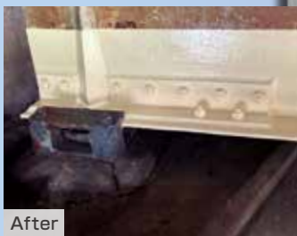
腐食損傷部の補修
