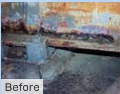
腐食損傷部の補修
