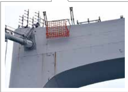
実際の施工箇所
