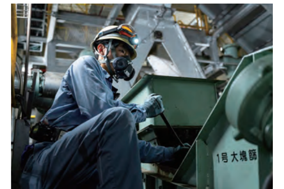
機械設備点検・整備
