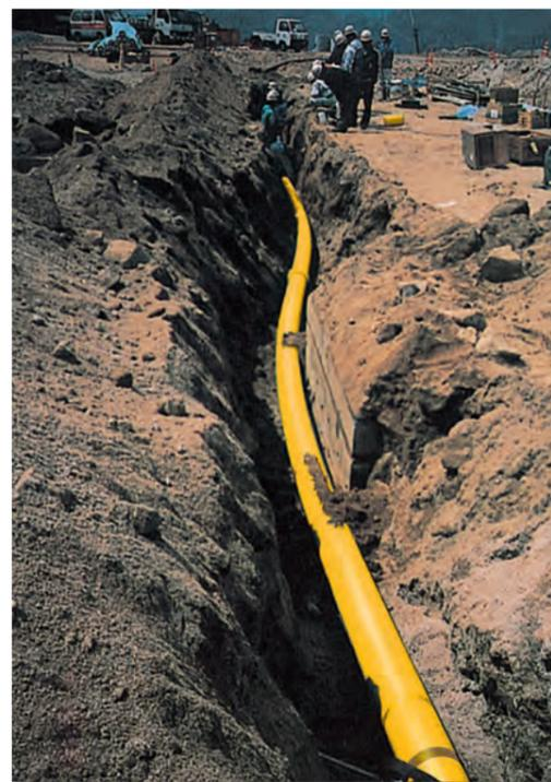
コイル管による非開削工法
