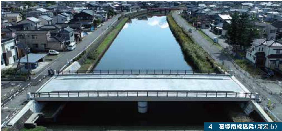
4 葛塚南線橋梁(新潟市)
