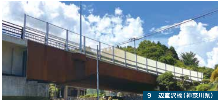
9 辺室沢橋(神奈川県)
