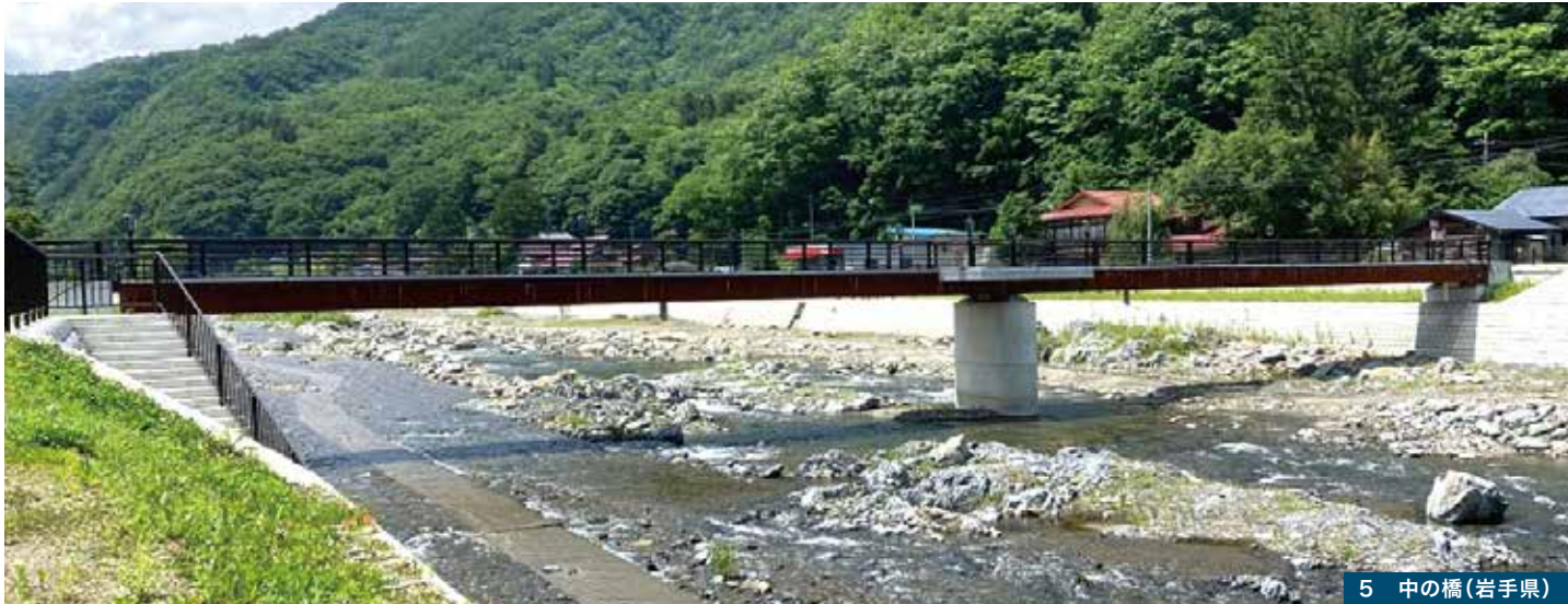
5 中の橋(岩手県)
