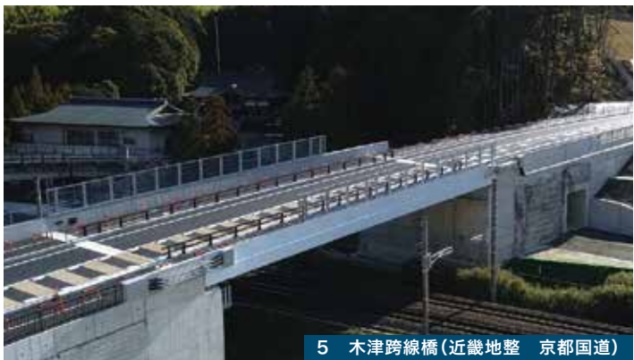
5 木津跨線橋(近畿地整 京都国道)
