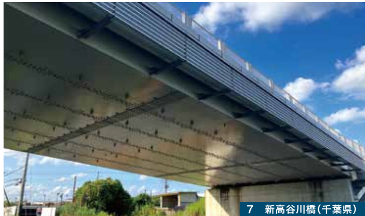
7 新高谷川橋(千葉県)
