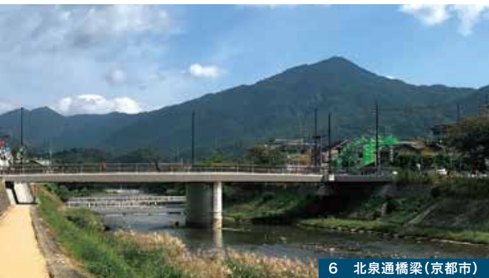
6 北泉通橋梁(京都市)
