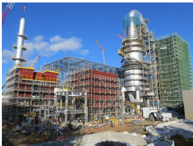
□ 平成 26 年度南相馬市対策地域内廃棄物処理業務(減容化処理) 現地
