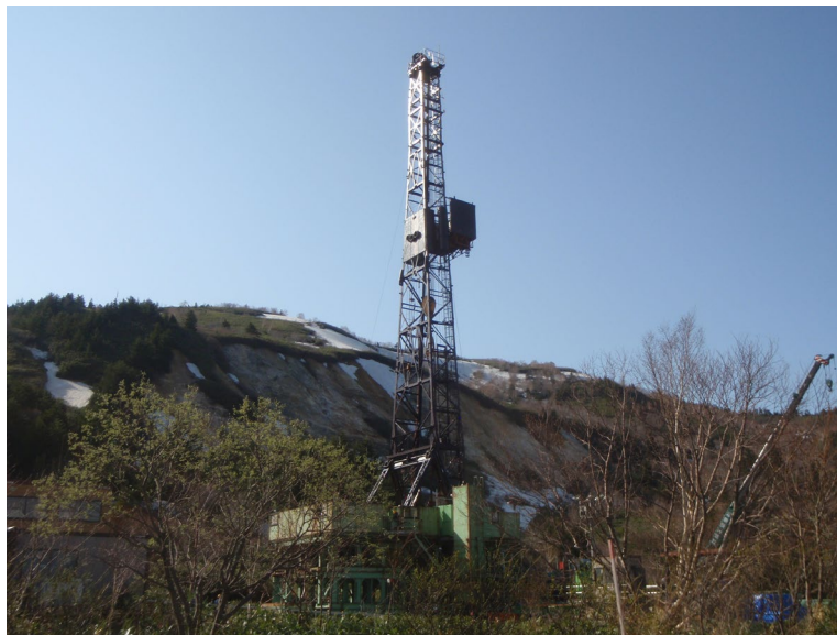
共同掘削調査を開始（中央は掘削用リグ）
