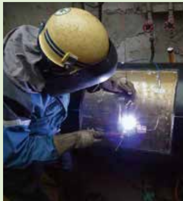
肉盛溶接 (ティグ溶接)
